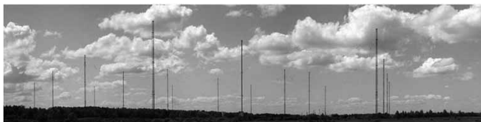
Рис. 19. Антенное поле сверхдлинноволновой радиостанции «Голиаф»
